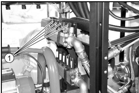
① Vanne d'arrêt pour chauffage de piste de lavage
